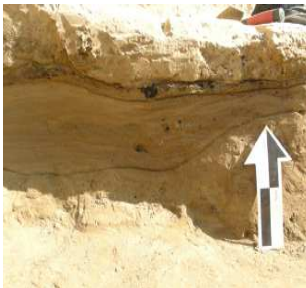
Figura 142. Evidencia de ingresos de agua en la estructura
